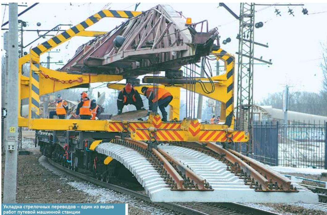
Укладка стрелочных переводов – один из видов работ путевой машинной станции
