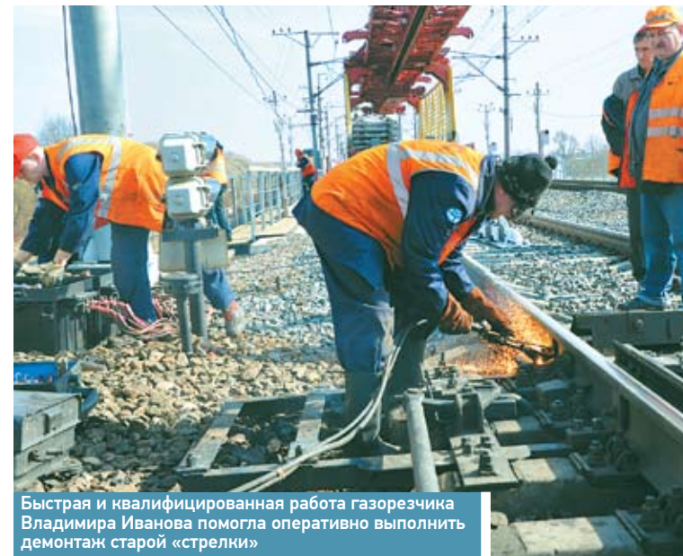
Специалисты ПМС-82 начинают монтаж самого длинного на ОЖД стрелочного перевода
